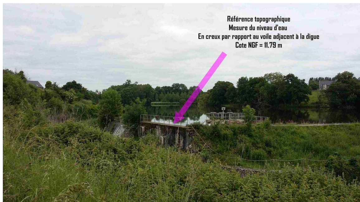
Figure 2 – Localisation de la référence topographique des mesures de niveau
